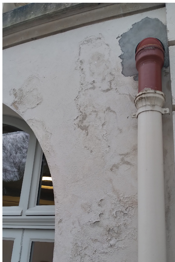
Photographie du mur de soutènement de la cour Ouest : marques d'humidité, écaillage de l'enduit, reprise au ciment > dégradation liée à une fuite de la descente EP ?
