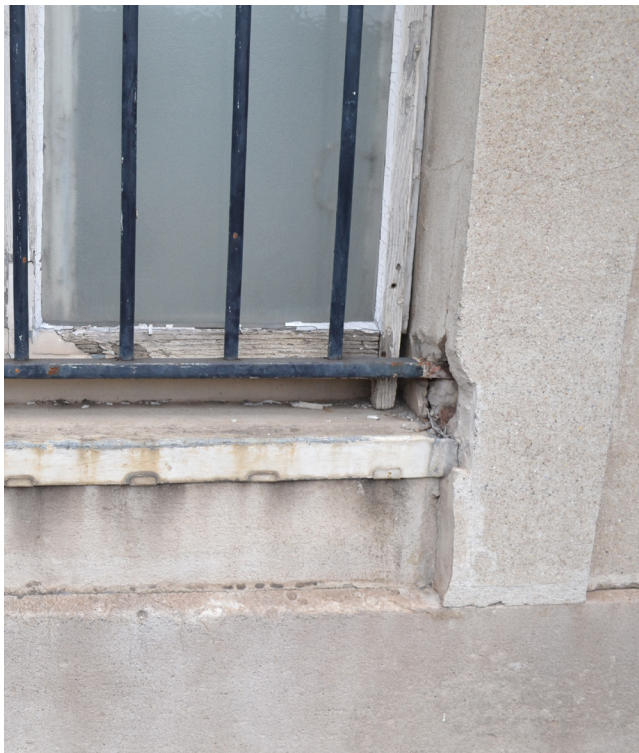
Photographie d'une des baies du bâtiment sur rue, élévation côté rue : oxydation de la grille de défense ayant fait éclater les maçonneries au niveau de l'encadrement de baie, altération de la menuiserie formant le pare-balle.
