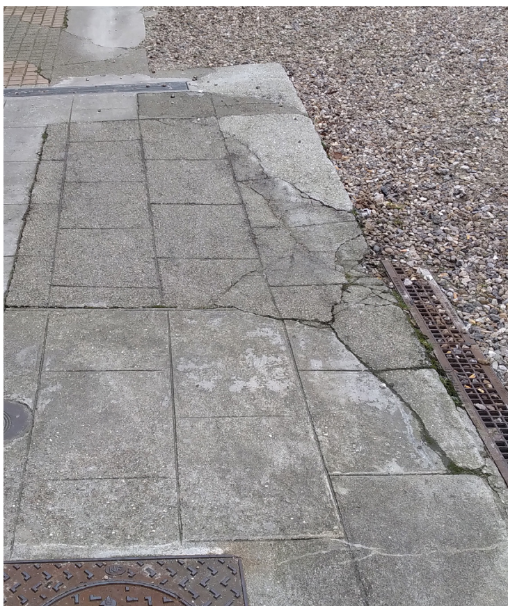
Photographie d'un des trottoirs en ciment de la cour : Fissuration, reprises en mortiers, présence de caniveaux à grilles encombrés par les gravillons de la cour
