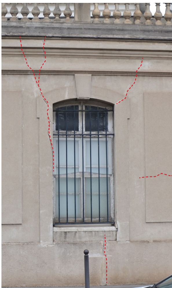
Photographie de la première travée côté Est : fissuration en biais au niveau de la baie qui remonte à travers la corniche jusqu'en haut de la balustrade, fissuration horizontale
