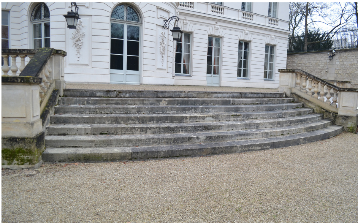
Photographie du perron sur le jardin : colonisation biologique de l'embranchement et des balustrades en pierres
