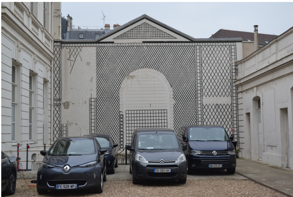
Photographie de la cour d'honneur du mur mitoyen Est : Hétérogénéité des traitements de sols, altération de l'enduit du mur mitoyen, treillage lacunaire et en très mauvais état.
