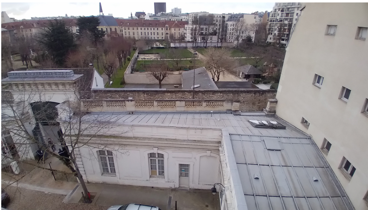
Photographie de la couverture de l'aile Ouest du bâtiment sur rue : vieillissement du zinc, verrière couverte de tôles oxydées, couverture du portail central en plomb vieillissante
