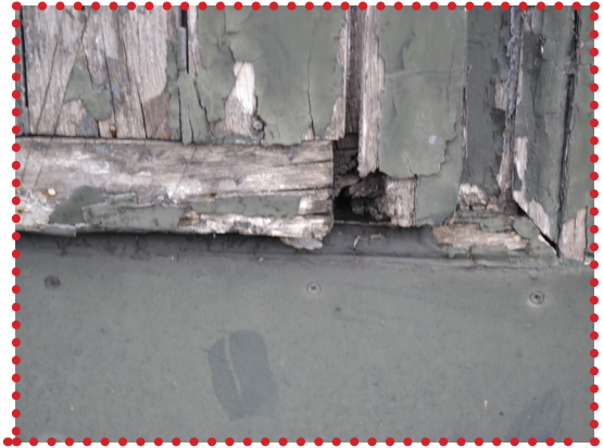
Photographies de la porte cochère située en extrémité Ouest de la façade sur rue : peinture écaillée, altération des panneaux bas, déformation des vantaux
