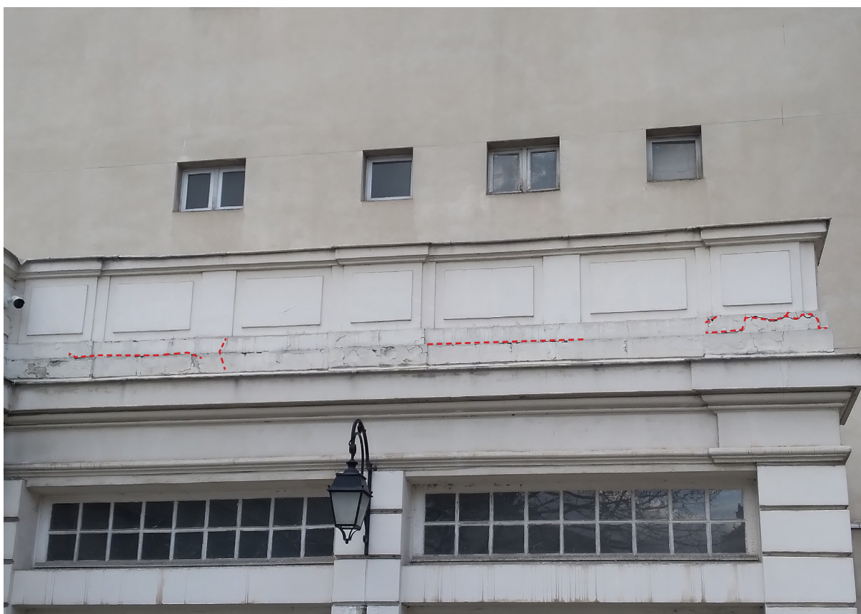
Photographie du parapet du bâtiment sur rue sur rue côté cour : altération de l'enduit et écaillage de la peinture, marques d'humidité, fissuration profondes des maçonneries
