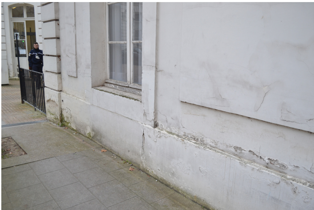
Photographie des soubassements du bâtiment sur rue côté cour : marques d'humidité, colonisation biologique, écaillage de la peinture et de l'enduit
