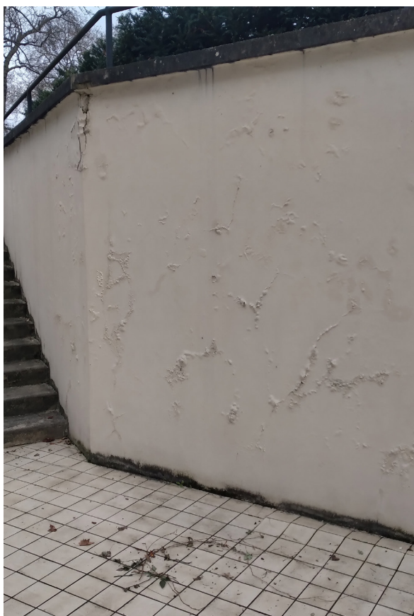
Photographie du mur de soutènement de la cour Est : marques d'humidité, fissuration et écaillage de l'enduit, fissuration liée à l'oxydation du garde-corps métallique
