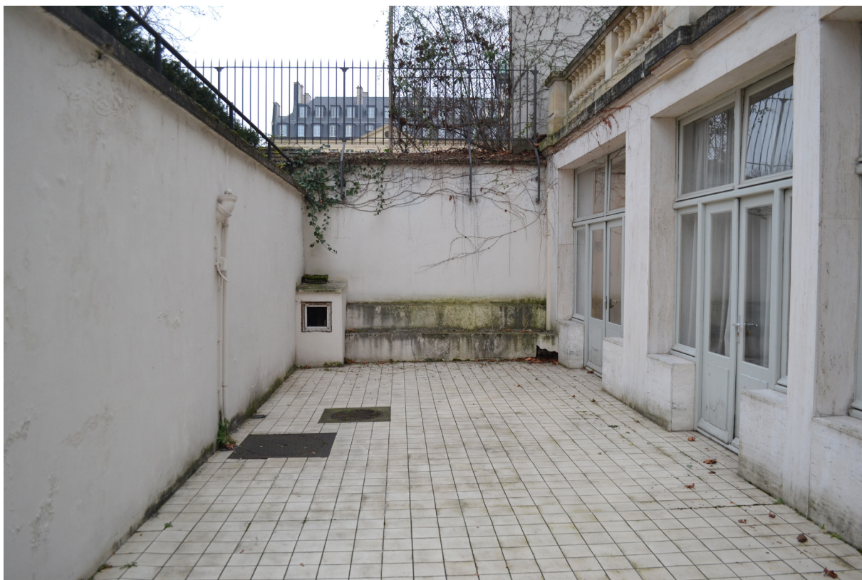
Photographie de la cour anglaise Est sur le jardin : humidité générale, colonisation biologique, banquette en ciment fortement dégradé
