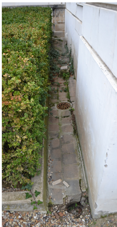
Photographie d'une cunette pavée au pied du logis : Fissuration, colonisation biologique, avaloir en fonte sous-dimensionné ?
