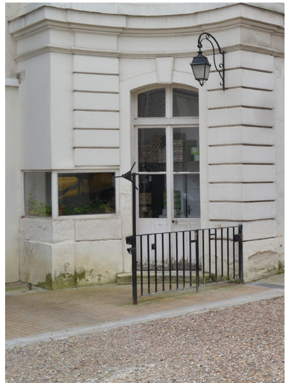
Photographie d'une des baies du bâtiment sur rue, élévation côté cour : altération des parties basses, peinture lacunaire. Baie en aluminium percé lors d'aménagements récents
