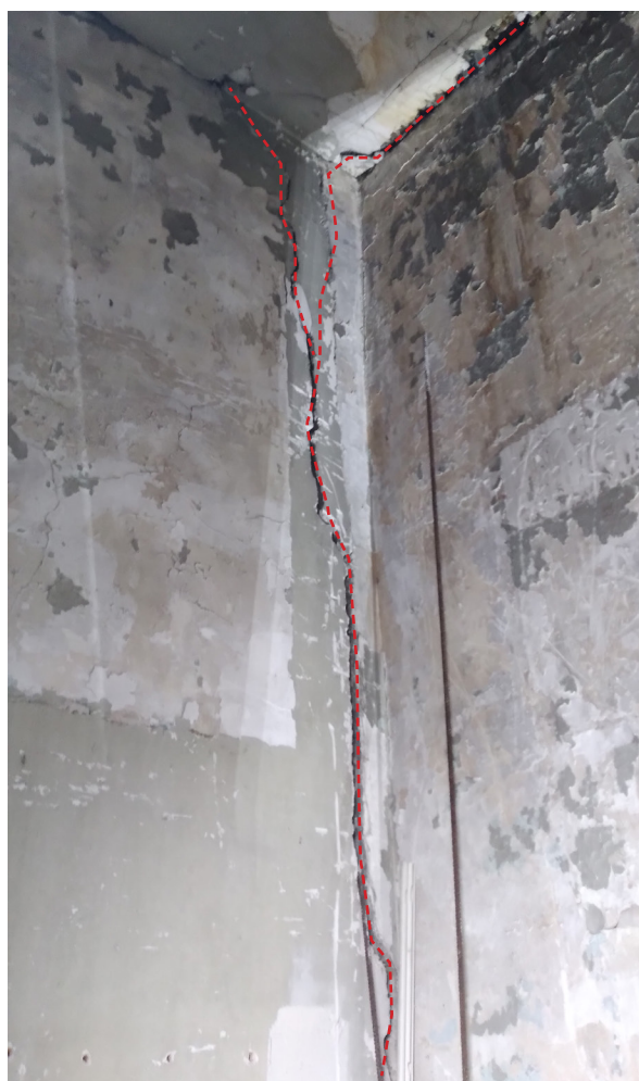
Photographie de la travée située contre le mur mitoyen Est : fissuration intérieure, marques d'infiltrations d'eaux pluviales
