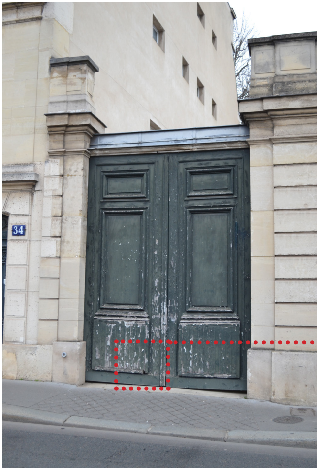
Photographies de la porte cochère située en extrémité Ouest de la façade sur rue : peinture écaillée, altération des panneaux bas, déformation des vantaux
