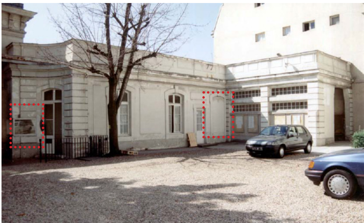
Façade sur cour : corps de bâtiment sur rue, septembre 1991. En rouge : la baie percée pour l'aménagement d'un local PCS, et le comblement d'une baie historique. Source : Cliché du cabinet Grahal. rapport historique d'août 2005.
